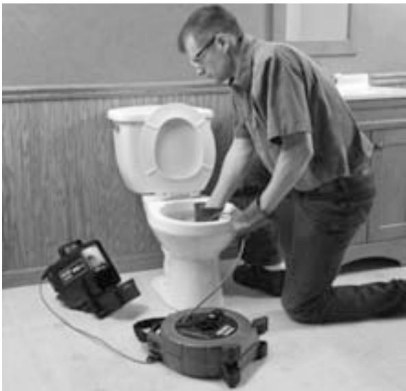
Abbildung 15 – Durchführung einer Inspektion
