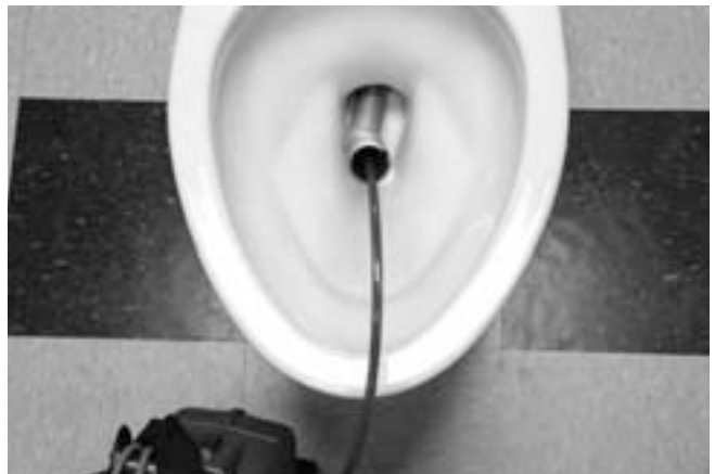
Abbildung 25 – Verwendung eines Führungsschlauchs
